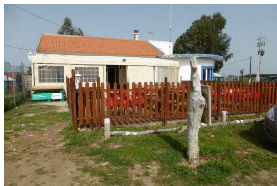
Vista geral do Bar - Restaurante, com esplanada coberta e descoberta.
