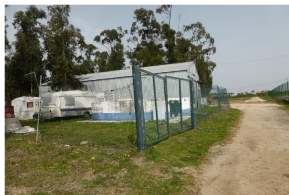
Hangar da manutenção, onde são guardadas ferramentas, equipamentos e materiais indispensáveis à manutenção e realização de tarefas oficiais.
