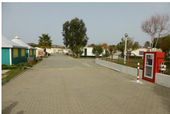
Vista geral do arruamento principal do parque, com Pagans (verde) para alugar e hidrante do sistema de combate a incêndios.
